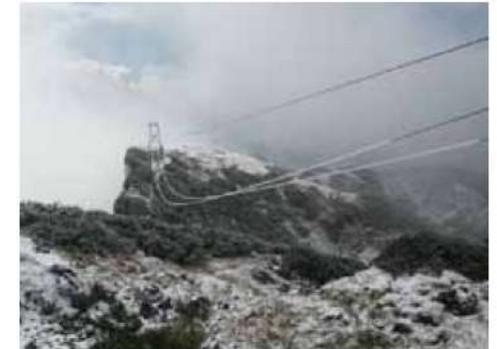
Schneelast sorgt für Seilrisse am Zugseil
